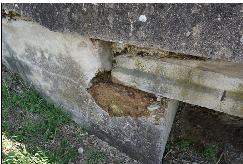
Rozpad levé strany opěry OP2.
