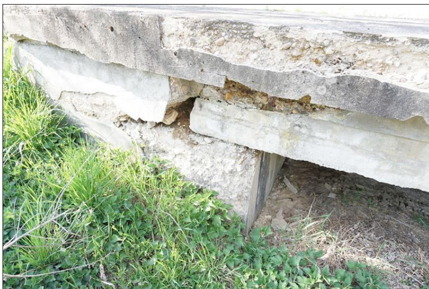
Rozpad pravé strany opěry OP1.
