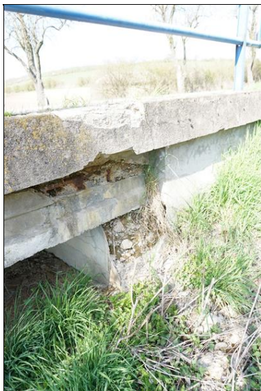
Rozpad pravé strany opěry OP2.
