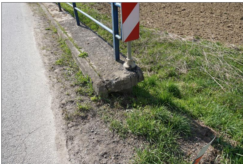
Detail nenávaznosti říms na okolní terén - opěra OP2 vlevo.
