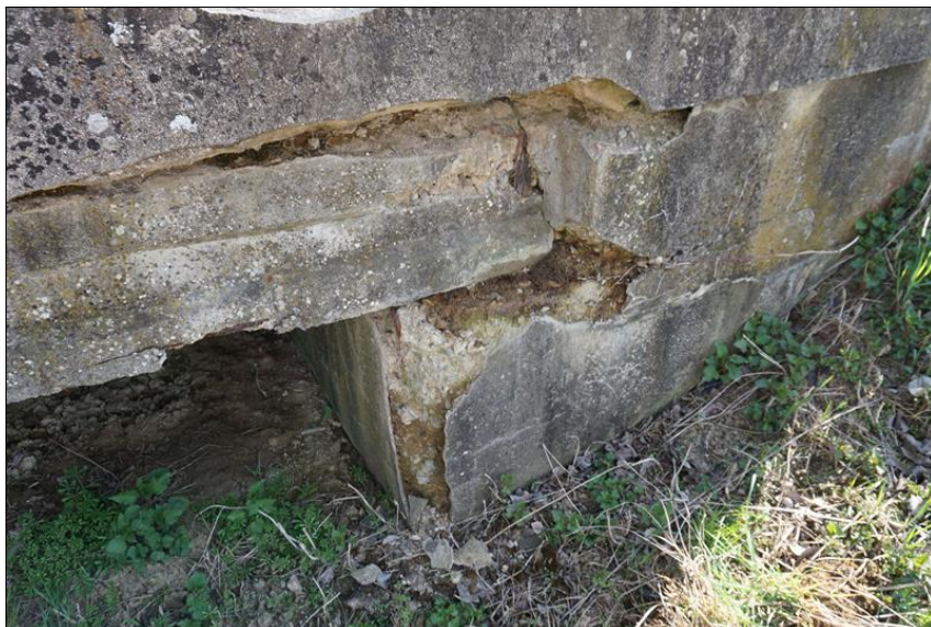
Rozpad levé strany opěry OP1.
